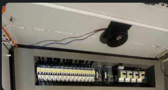
4. Položite vžigalno vrvico za diskom po mestu potencialnega vira ognja.
